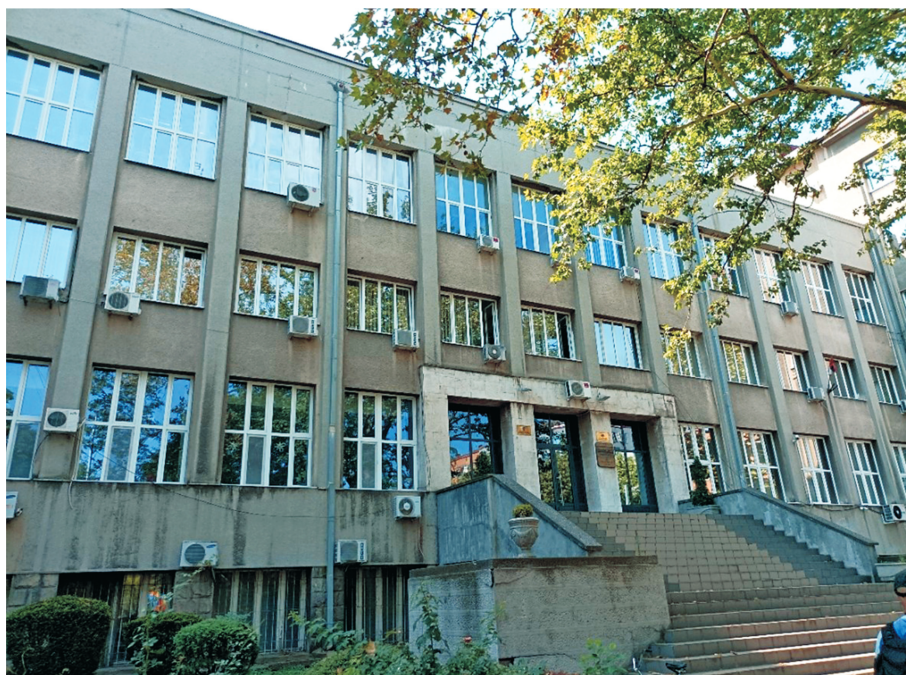
Илустрација 3: Прочеље, извор: фототографија ауторке, 16. јул 2024.
